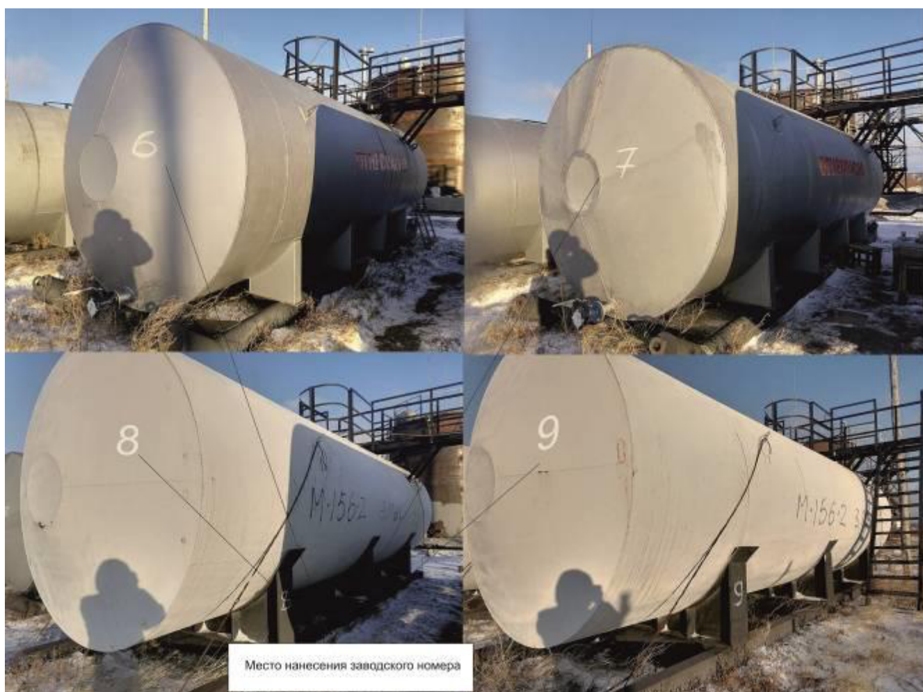
Рисунок 2 – Общий вид резервуаров горизонтальных стальных цилиндрических РГС-50 с указанием места нанесения заводских номеров
