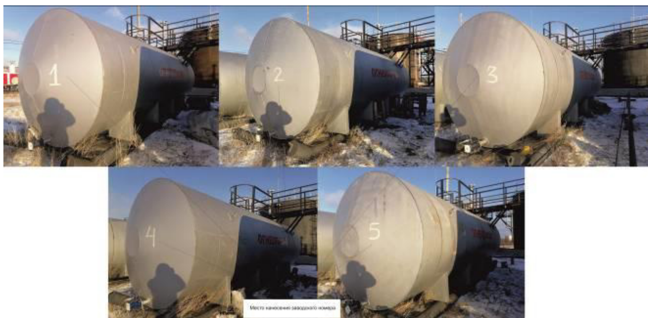
Рисунок 1 – Общий вид резервуаров горизонтальных стальных цилиндрических РГС-50 с указанием места нанесения заводских номеров
