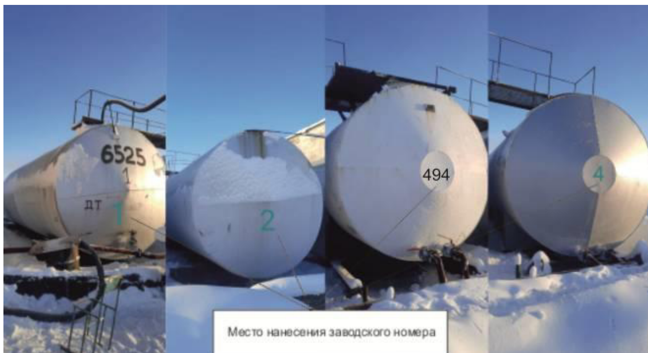
Рисунок 1 – Общий вид резервуаров горизонтальных стальных цилиндрических РГС с указанием места нанесения заводских номеров
