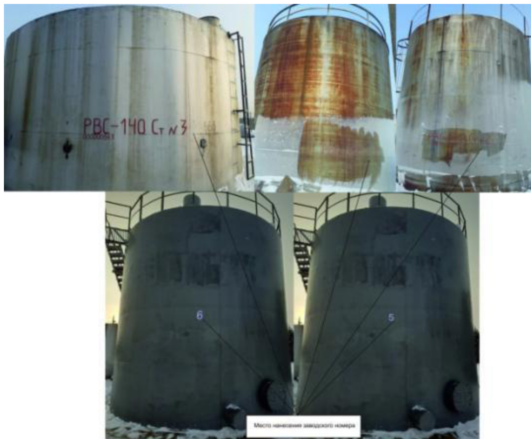
Рисунок 1 – Общий вид резервуаров вертикальных стальных цилиндрических PBC с указанием места нанесения заводских номеров
