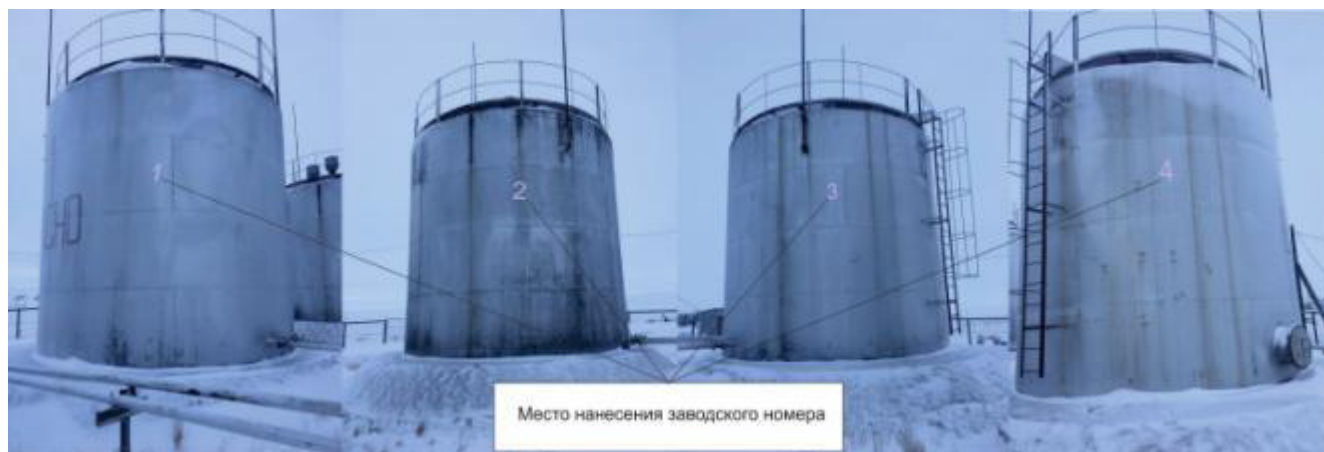
Рисунок 1 – Общий вид резервуаров вертикальных стальных цилиндрических РВС-200 с указанием места нанесения заводских номеров
