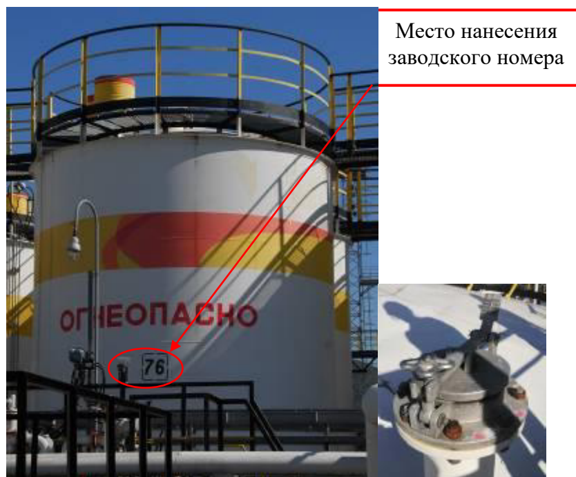
Рисунок 5 – Общий вид резервуара и замерного люка РВС-100 зав.№ 76
