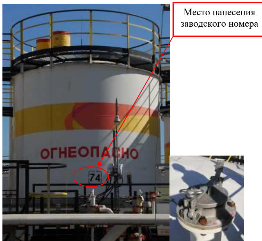
Рисунок 3 – Общий вид резервуара и замерного люка РВС-100 зав.№ 74
