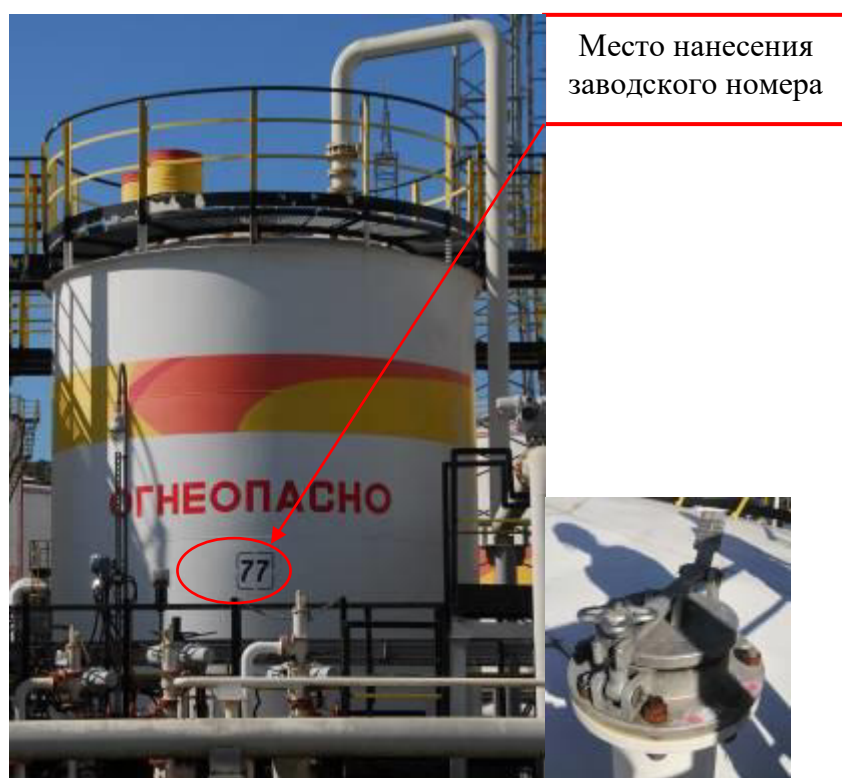
Рисунок 6 – Общий вид резервуара и замерного люка РВС-100 зав.№ 77
