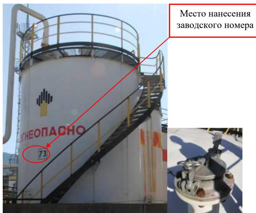
Рисунок 2 – Общий вид резервуара и замерного люка РВС-100 зав.№ 73
