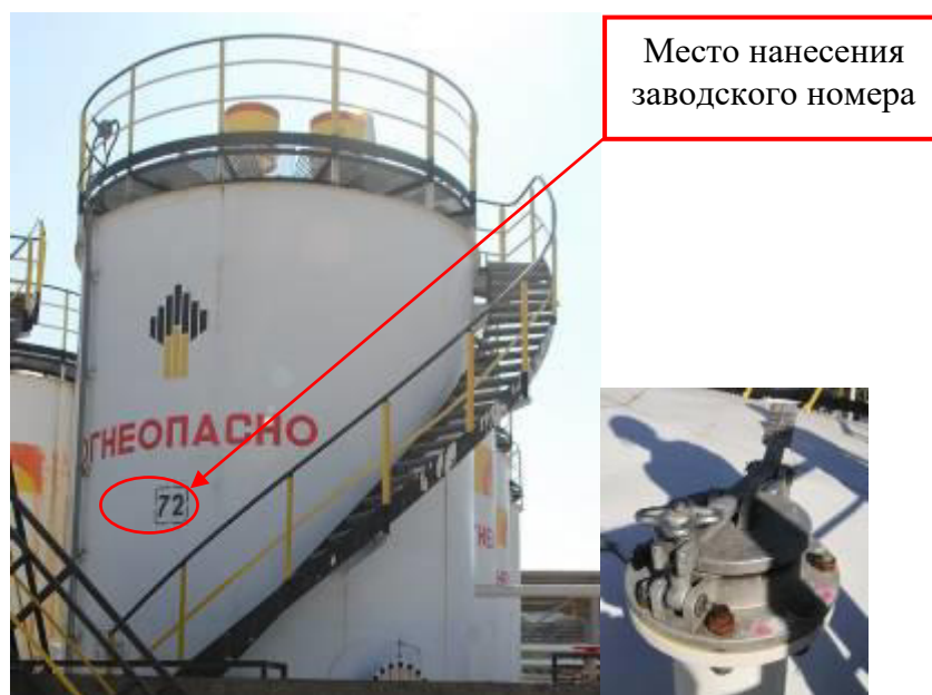
Рисунок 1 – Общий вид резервуара и замерного люка РВС-100 зав.№ 72
