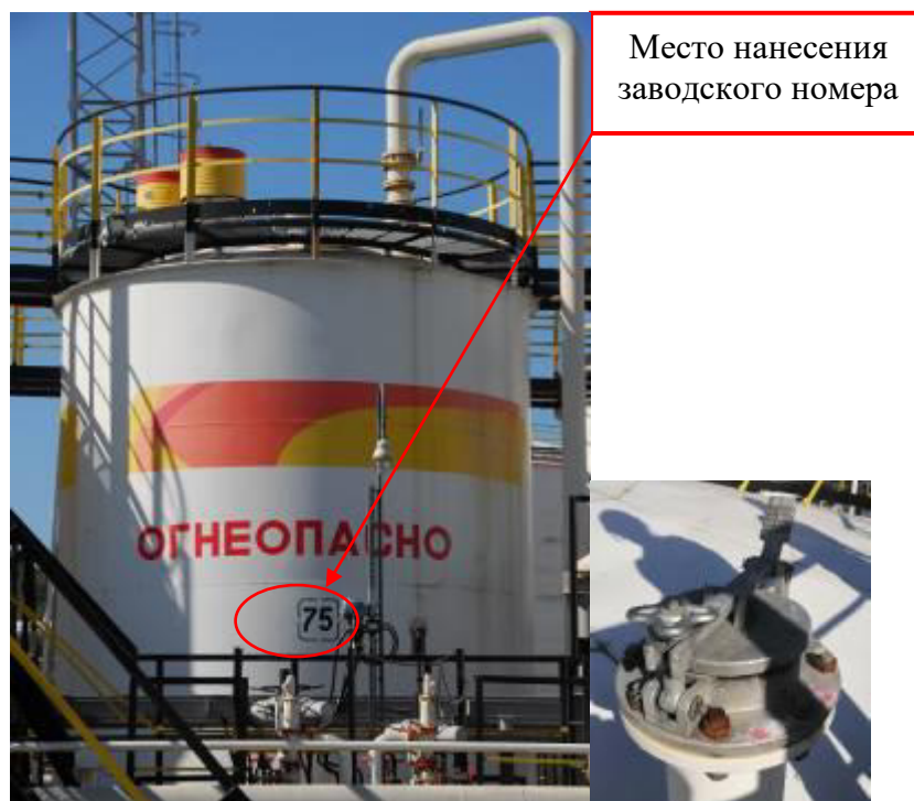
Рисунок 4 – Общий вид резервуара и замерного люка РВС-100 зав.№ 75
