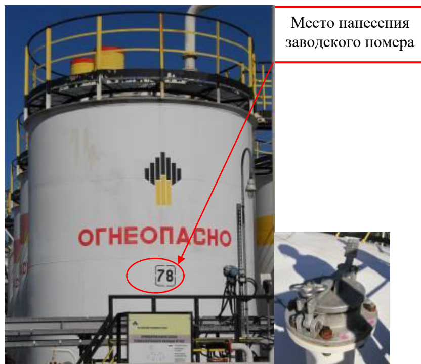
Рисунок 7 – Общий вид резервуара и замерного люка РВС-100 зав.№ 78
