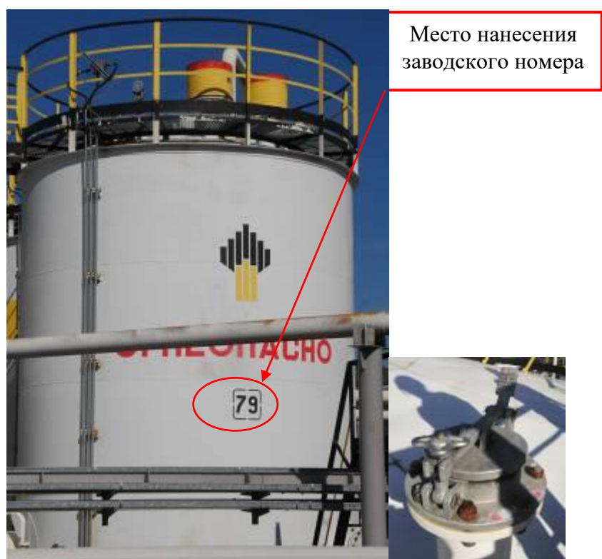
Рисунок 8 – Общий вид резервуара и замерного люка РВС-100 зав.№ 79
