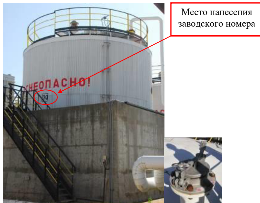
Рисунок 1 – Общий вид резервуара и замерного люка РВС-400 зав.№ 70
