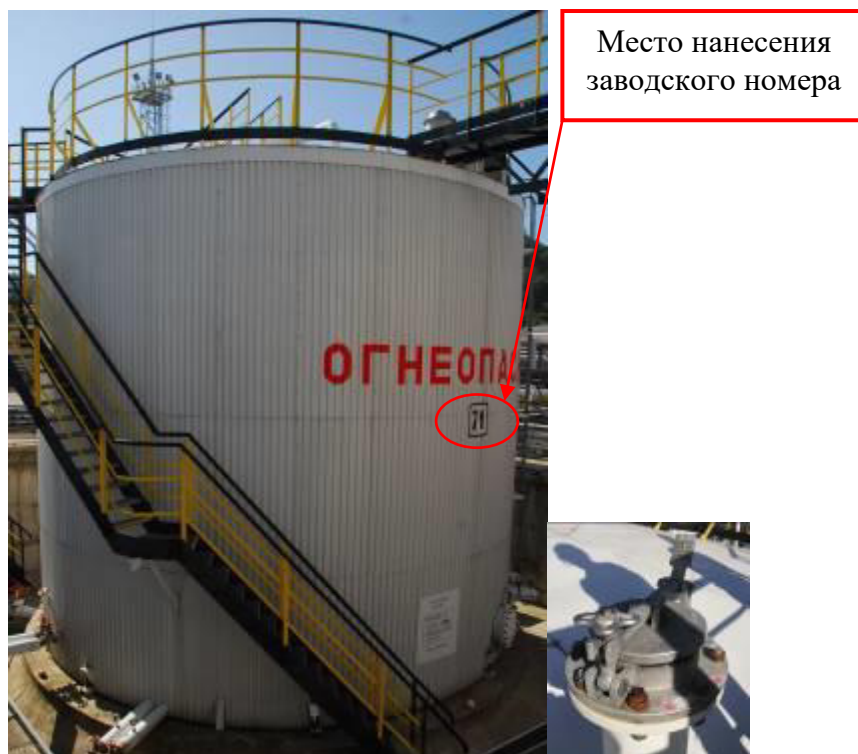
Рисунок 2 – Общий вид резервуара и замерного люка РВС-400 зав.№ 71
