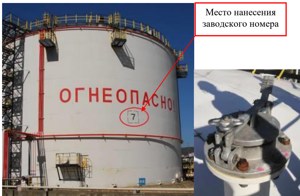
Рисунок 1 – Общий вид резервуара и замерного люка РВСП-10000 зав.№ 7
