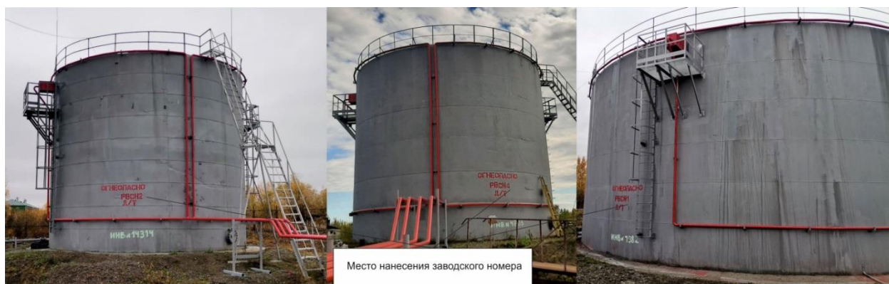
Рисунок 1 – Общий вид резервуаров вертикальных стальных цилиндрических PVC с указанием места нанесения заводских номеров
