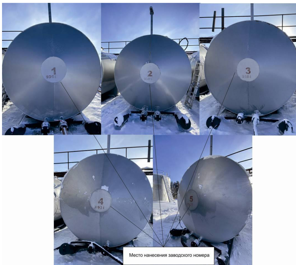
Рисунок 1 – Общий вид резервуаров горизонтальных стальных цилиндрических РГС-50 с указанием места нанесения заводских номеров
