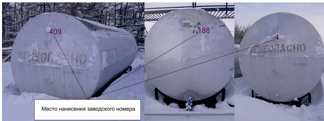
Рисунок 1 – Общий вид резервуаров горизонтальных стальных цилиндрических РГС с указанием места нанесения заводских номеров
