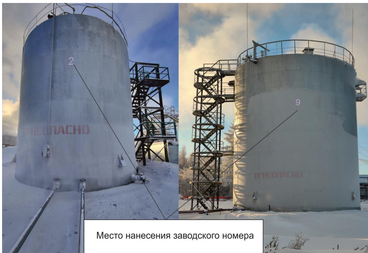
Рисунок 1 – Общий вид резервуаров вертикальных стальных цилиндрических РВС с указанием места нанесения заводских номеров
