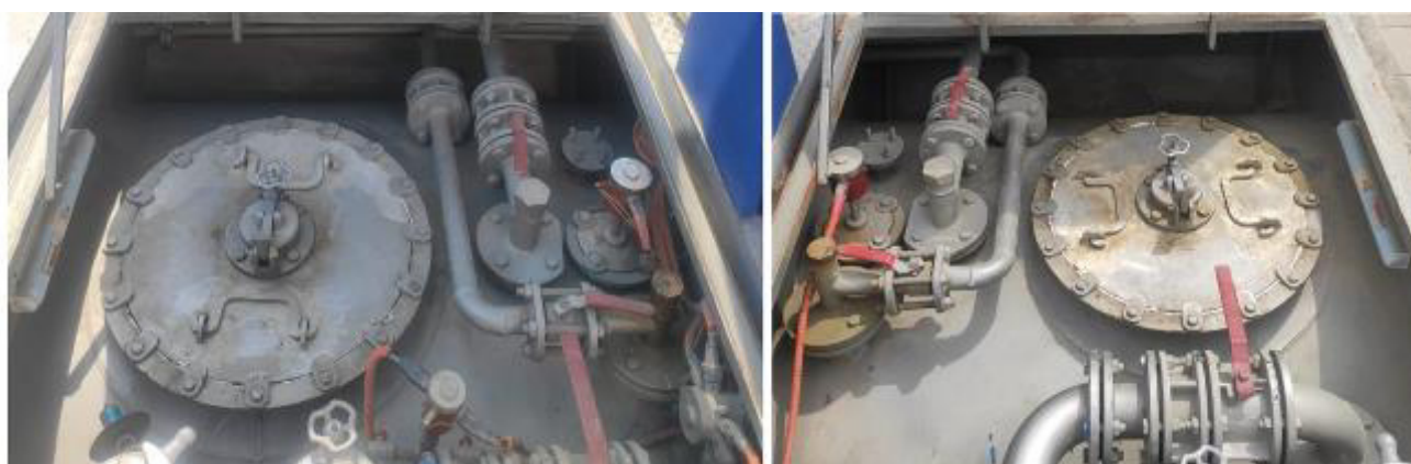
Рисунок 3 – Горловины и измерительные люки резервуара РГ20(10/10) зав.№ 3076 Пломбирование резервуара РГ20(10/10) не предусмотрено.
