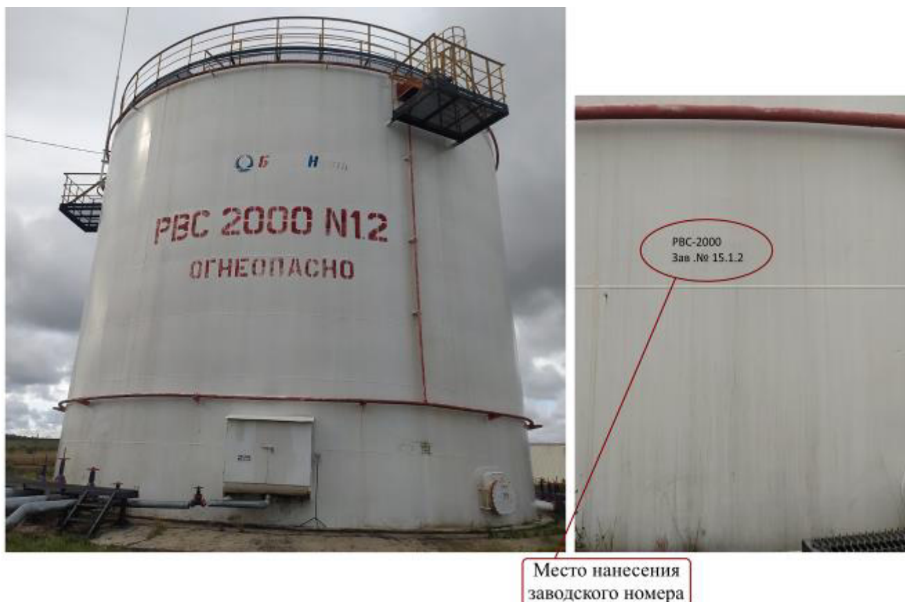
Рисунок 1 – Общий вид резервуара РВС-2000 №15.1.2
