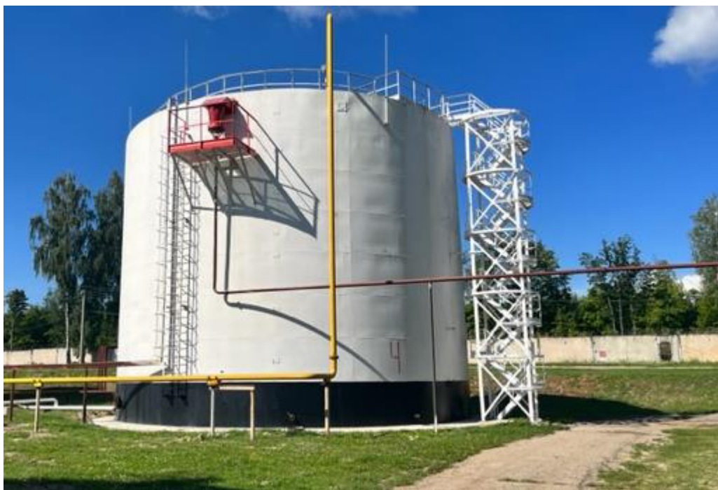
Рисунок 1 – Общий вид резервуара РВС-2000 №4
