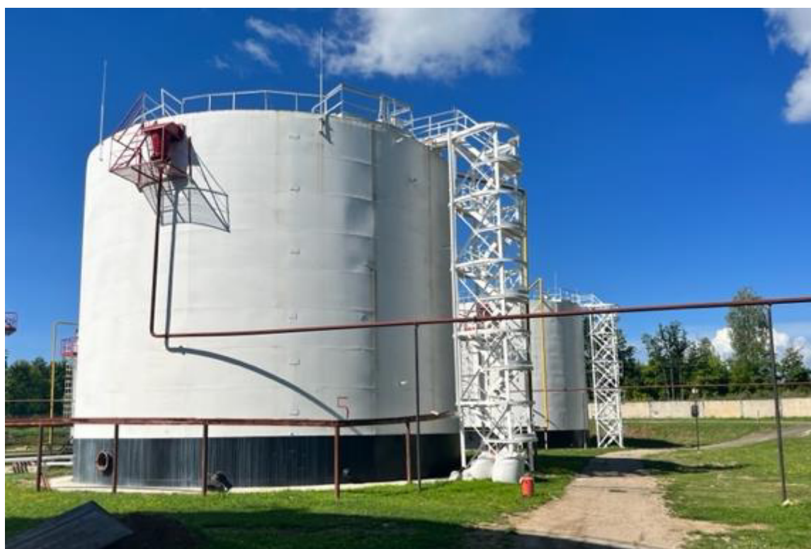
Рисунок 2 – Общий вид резервуара РВС-2000 №5
