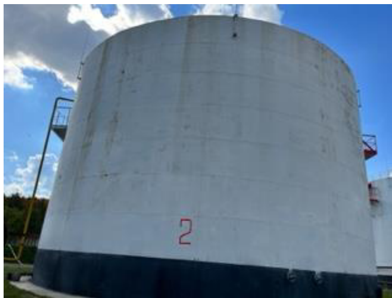
Рисунок 2 – Общий вид резервуара РВС-3000 №2
