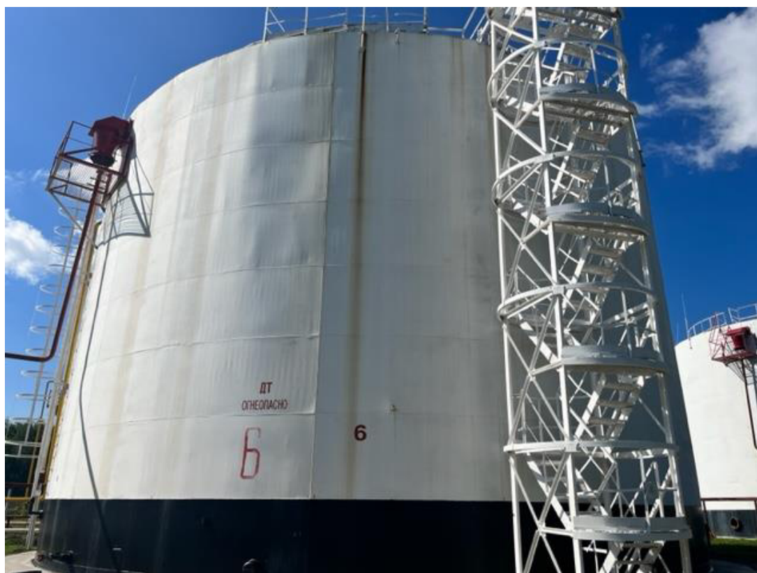
Рисунок 4 – Общий вид резервуара РВС-3000 №6 Пломбирование резервуаров РВС-3000 не предусмотрено.
