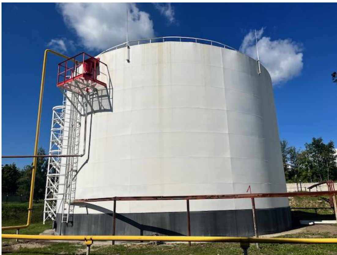
Рисунок 1 – Общий вид резервуара РВС-3000 №1
