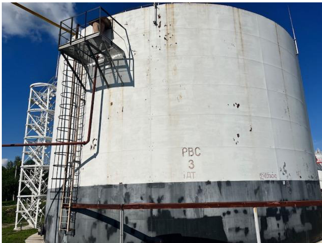
Рисунок 3 – Общий вид резервуара РВС-3000 №3
