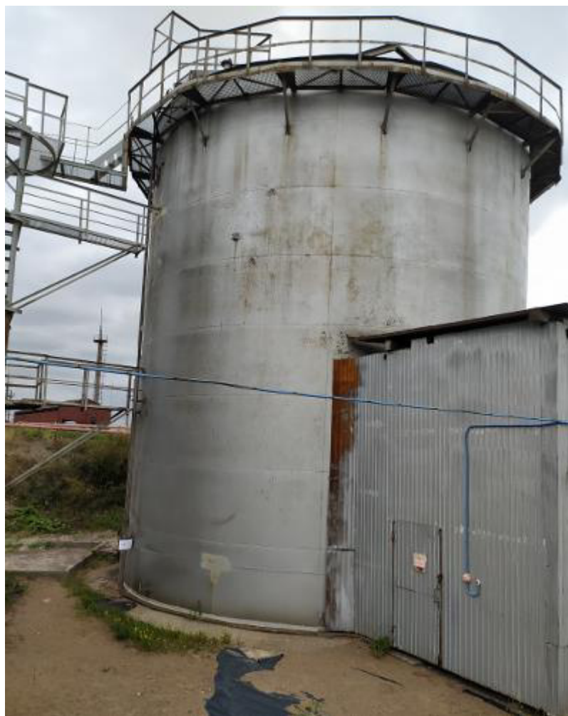
Рисунок 3 – Общий вид резервуара РВС-1000 №2
