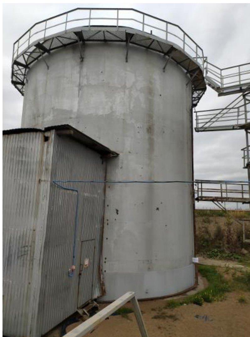
Рисунок 2 – Общий вид резервуара РВС-1000 №1
