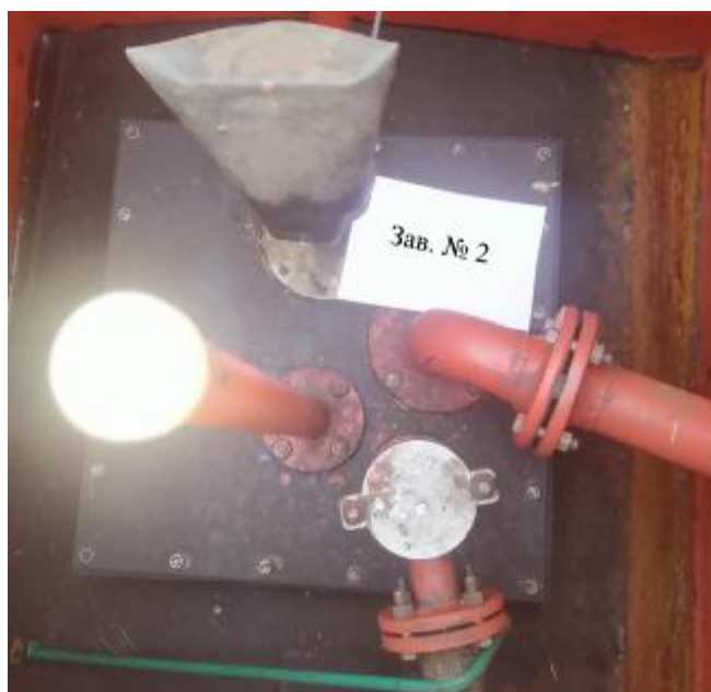
Рисунок 2 – Горловины резервуаров РГС-25 зав.№№2, 3
