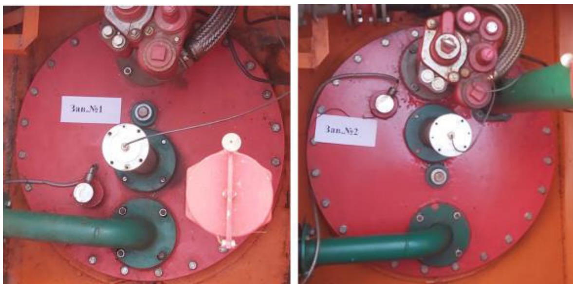
Рисунок 3 – Горловины резервуаров РГС-25 зав.№№ 1, 2
