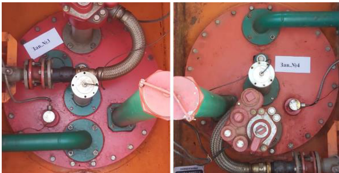
Рисунок 4 – Горловины резервуаров РГС-25 зав.№№ 3, 4
