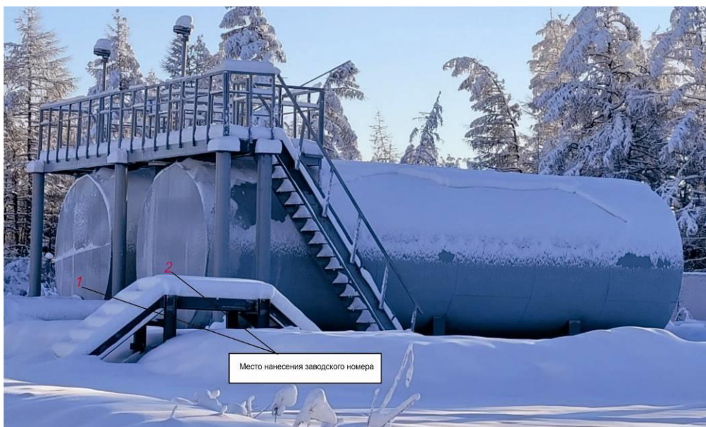
Рисунок 1 – Общий вид резервуаров горизонтальных стальных цилиндрических РГС-50 с указанием места нанесения заводских номеров
