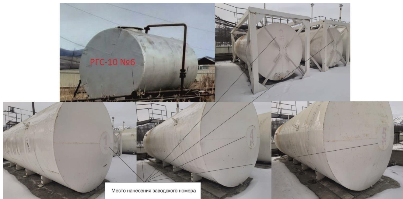
Рисунок 1 – Общий вид резервуаров горизонтальных стальных цилиндрических РГС с указанием места нанесения заводских номеров
