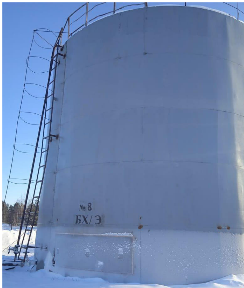
Рисунок 1 – Общий вид резервуара вертикального стального цилиндрического РВС-400
