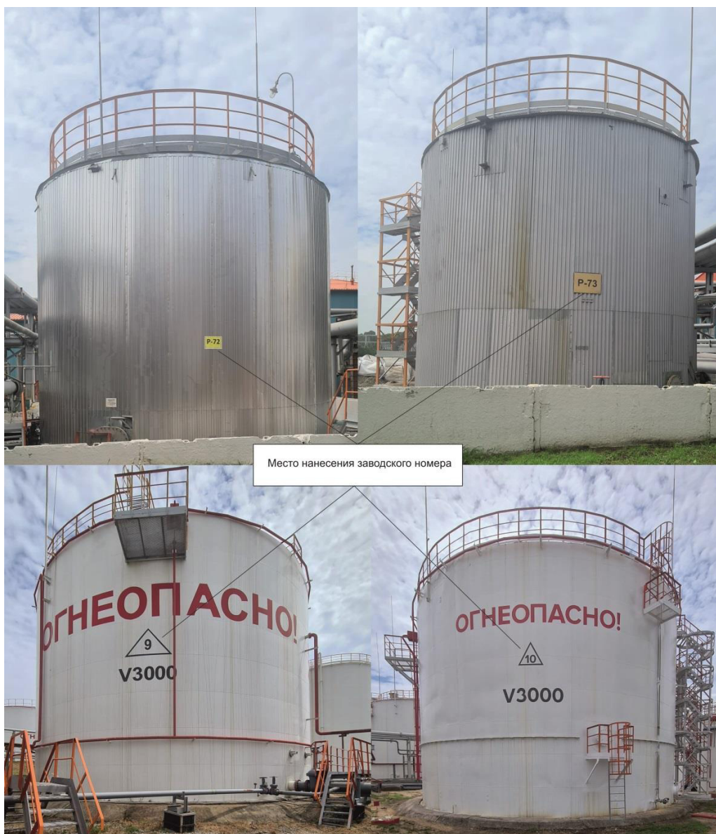
Рисунок 1 – Общий вид резервуаров вертикальных стальных цилиндрических РВС с указанием места нанесения заводских номеров
