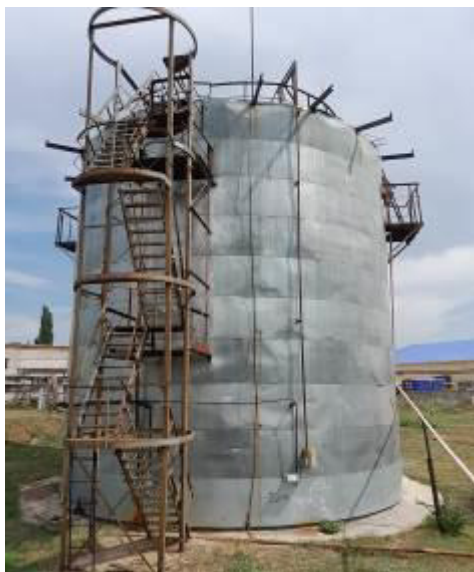
Рисунок 1 – Общий вид резервуара стального вертикального цилиндрического РВС-1000
