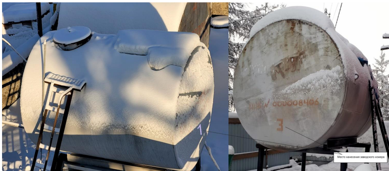
Рисунок 1 – Общий вид резервуаров горизонтальных стальных цилиндрических РГС-10 с указанием места нанесения заводских номеров
