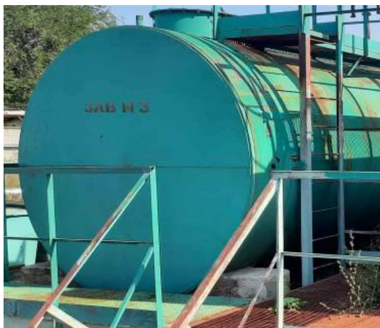
Рисунок 1 – Общий вид резервуара стального горизонтального цилиндрического РГС-25 заводской номер 3
