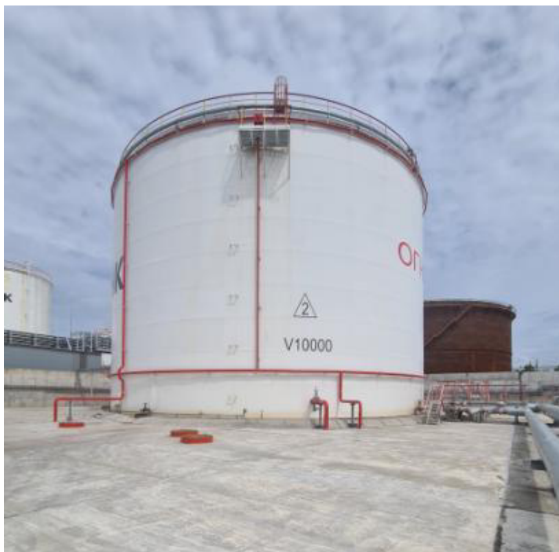
Рисунок 1 – Общий вид резервуара вертикального стального цилиндрического РВС-10000 №2
