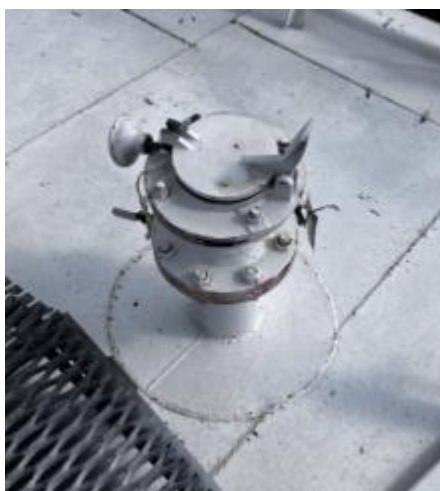
Рисунок 2 – Фото замерного люка резервуаров РВС-3000
