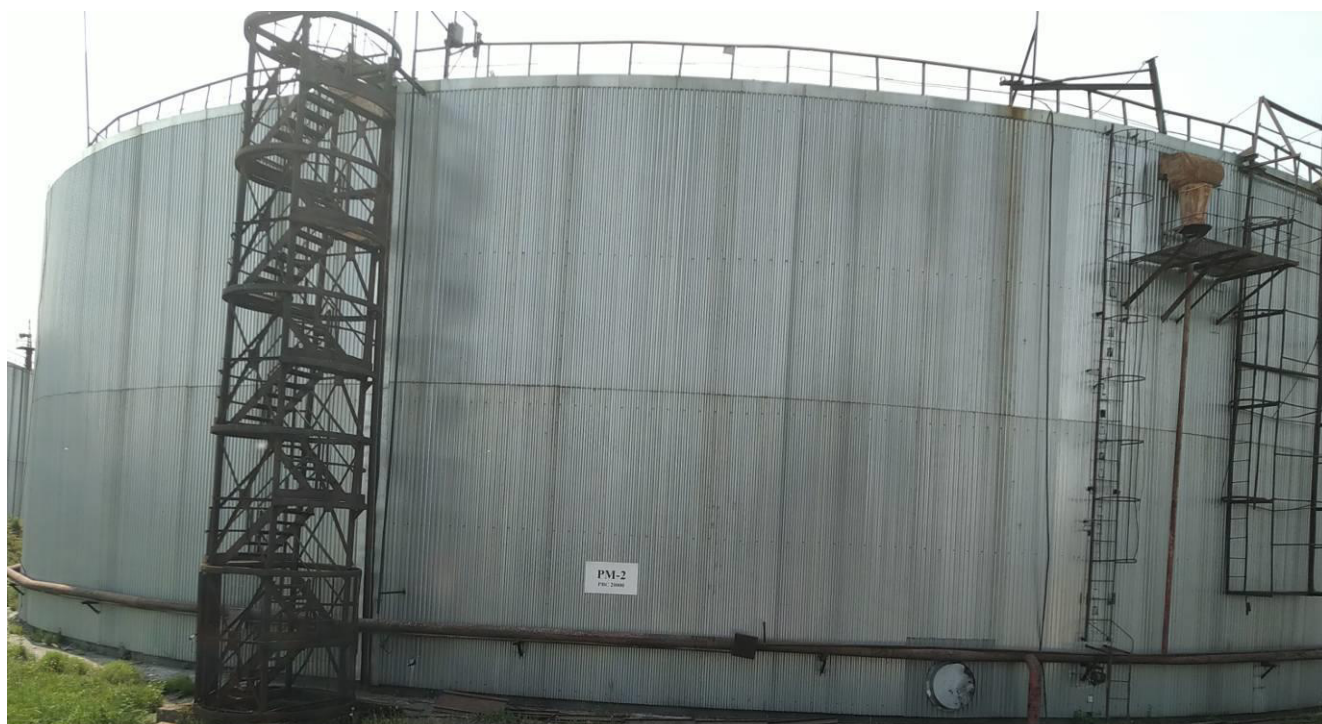
Рисунок 1 – Общий вид резервуара РВС-20000 зав.№ РМ-2
