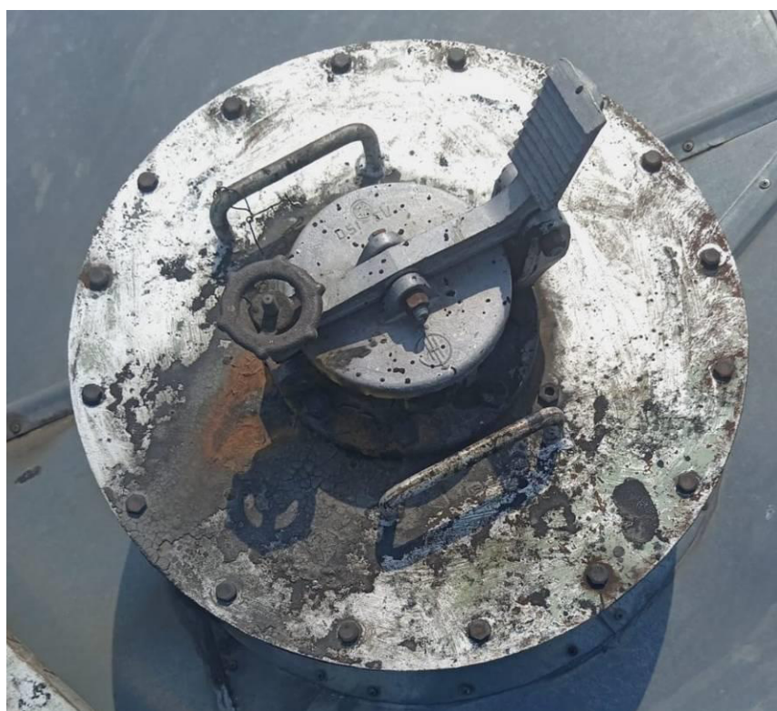
Рисунок 2 – Фото замерного люка резервуара РВС-20000 зав.№ РМ-2
