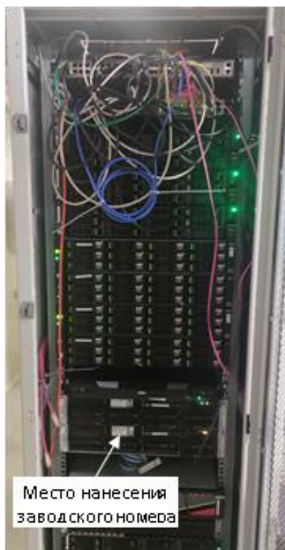
Рисунок 1 - Общий вид СБД ООО «РКС-энерго» АИИС КУЭ с указанием места нанесения заводского номера.
