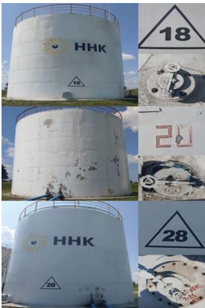
Рисунок 1 – Фотографии общего вида резервуаров стальных вертикальных цилиндрических РВС- 700, горловин замерных люков и заводских номеров
