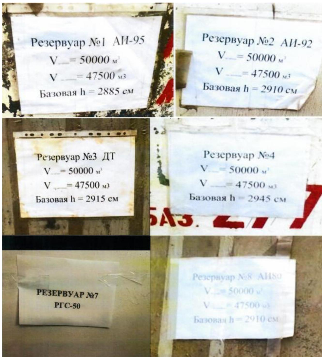
Рисунок 3 – Место нанесения заводского номера резервуаров РС-50
