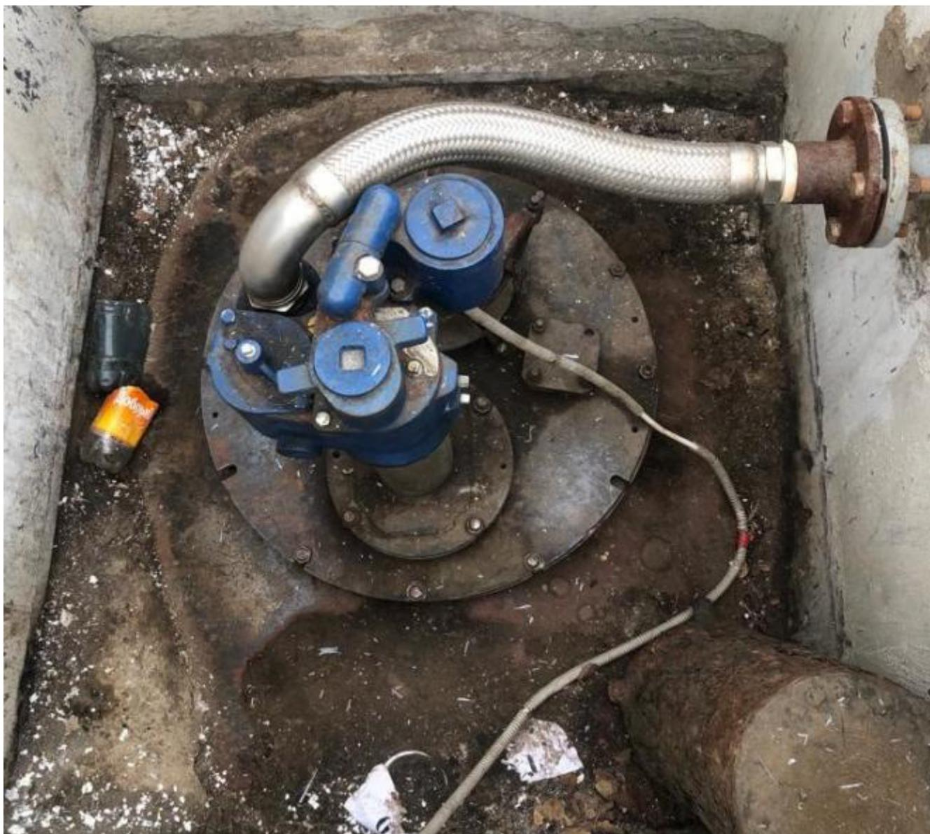
Рисунок 4 – Фото горловины и замерного люка резервуаров РГС-50
