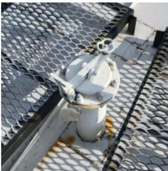
Рисунок 3 – Фото замерного люка резервуаров PBC-5000
