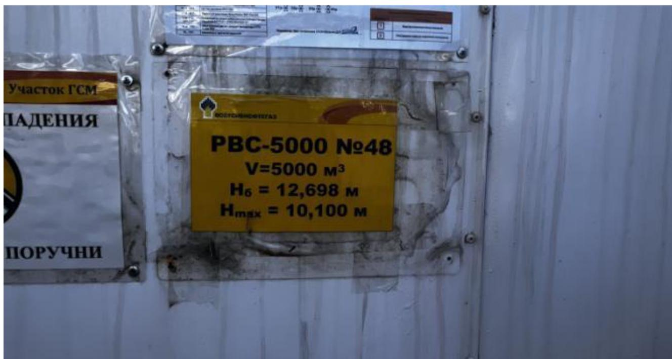
Рисунок 2 – Пример нанесения заводского номера PVC-5000
