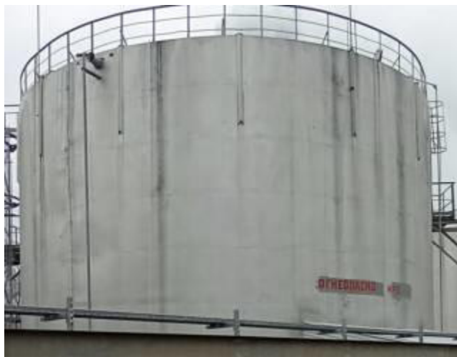
Рисунок 1 - Общий вид резервуаров стальных вертикальных цилиндрических РВС-2000
