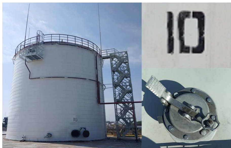
Рисунок 1 – Фотография общего вида резервуара стального вертикального цилиндрического РВС- 2000, горловины замерного люка и заводского номера
