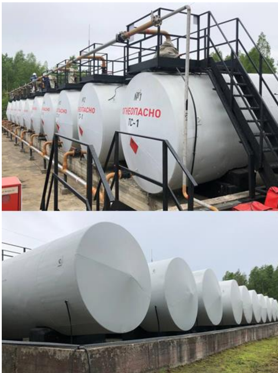
Рисунок 1 – Общий вид резервуаров РГС-50
