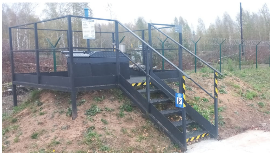
Рисунок 1 – Общий вид резервуара РГС-25
