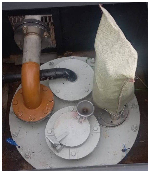
Рисунок 3 – Общий вид горловины и замерного люка резервуара РГС-25
