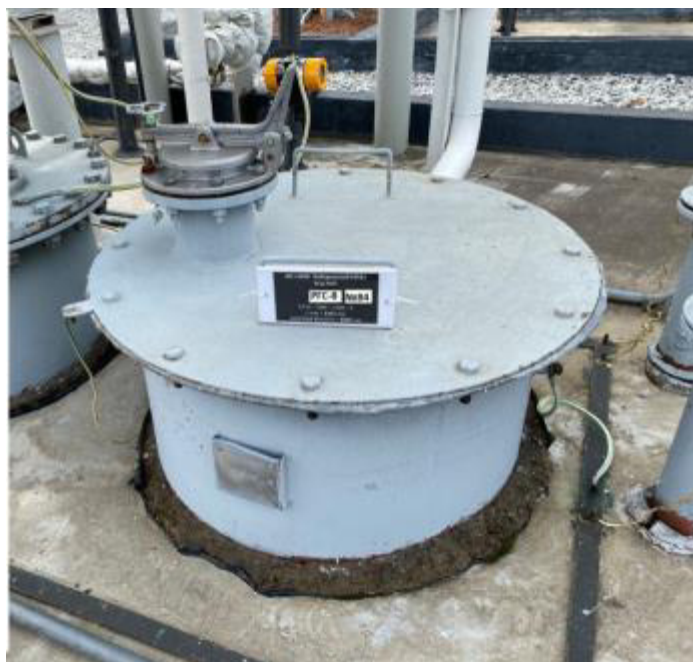
Рисунок 1 – Общий вид резервуара РГС-8
