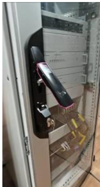
Рисунок 2 – Стойка СУ. Замок двери
