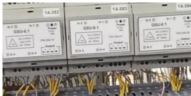
Рисунок 6 – Блоки гальванической развязки GSU-0.1
