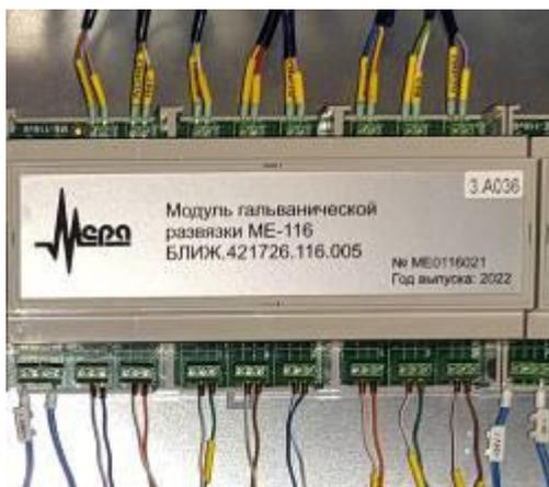
Рисунок 5 – Модуль гальванической развязки ME-116
