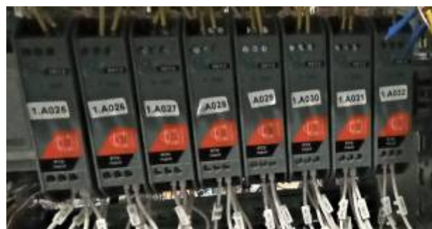
Рисунок 6 – Блок гальванической развязки и преобразования сопротивления в напряжение ICP DAS SG-3013
