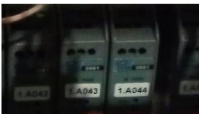
Рисунок 7 – Блок гальванической развязки и преобразования тока в напряжение ICP DAS SG-3081
