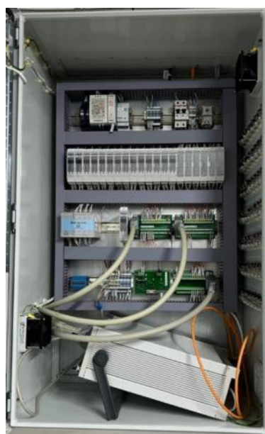
Рисунок 7 – Кросс-шкаф 3 с закрытой и открытой дверцей
