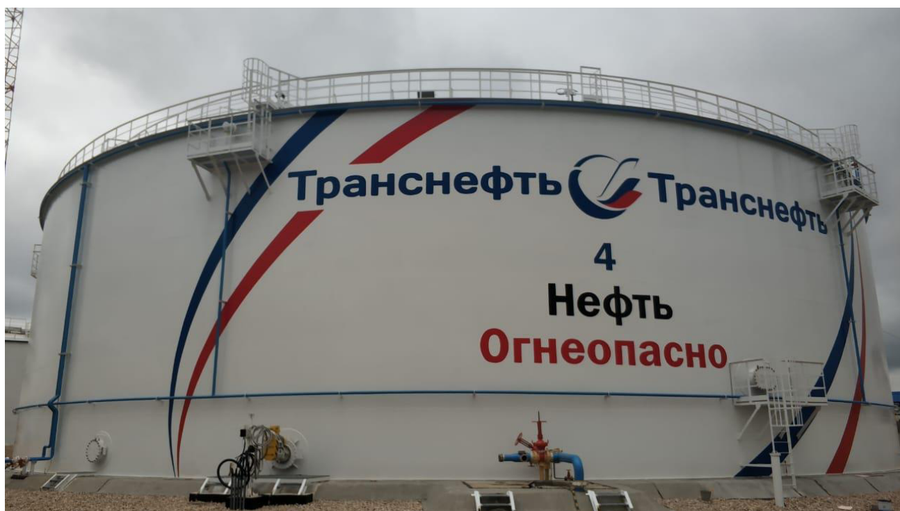
Рисунок 1 – Общий вид резервуара РВСП-20000 №4
