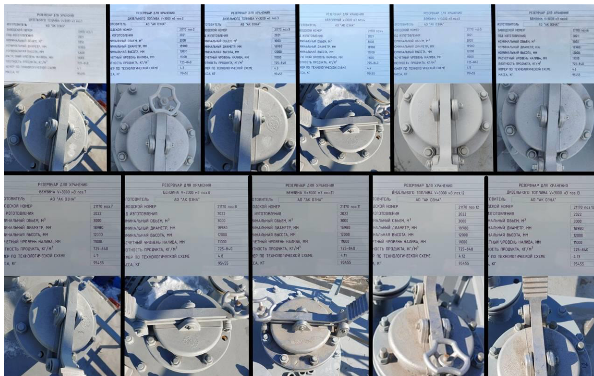
Рисунок 3 – Фотографии общего вида горловин и заводских номеров резервуаров вертикальных цилиндрических стальных с понтоном РВСп-3000
