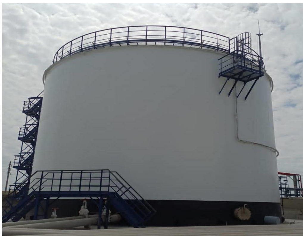
Рисунок 2 – Фотография общего вида резервуаров вертикальных цилиндрических стальных с понтоном РВСп-3000
