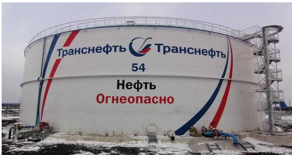
Рисунок 1 – Общий вид резервуара РВС-20000
