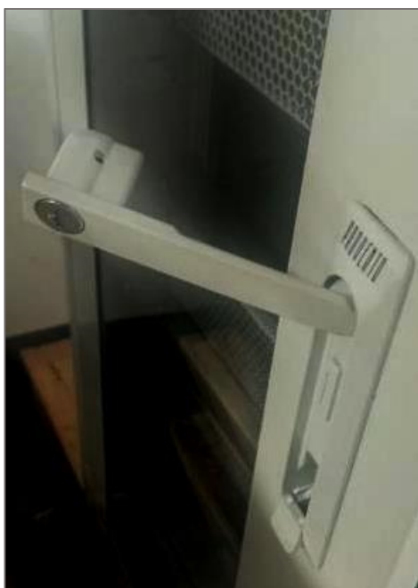
Рисунок 5 – Запирающий механизм стойки
