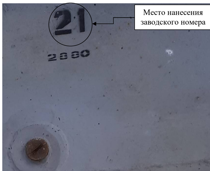
Р и с у н о к 3 – Общий вид замерного люка и места нанесения заводского номера
