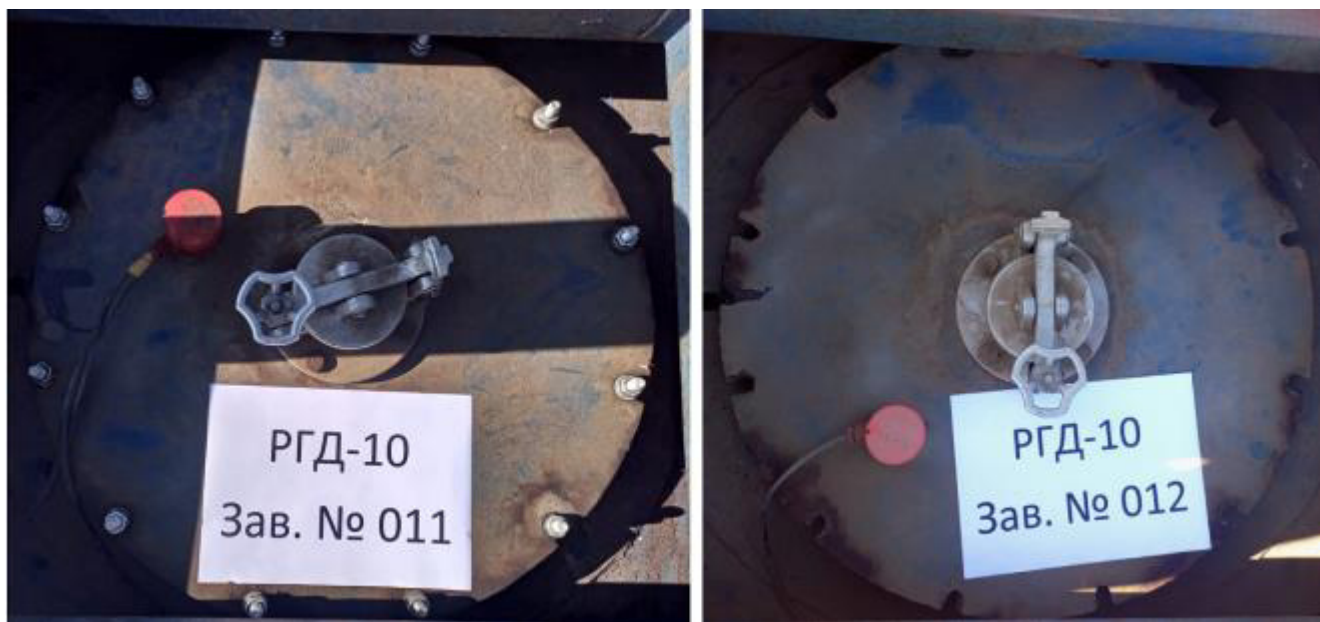
Рисунок 3 – Горловины и измерительные люки резервуаров РГД-10 зав.№№ 011, 012 Пломбирование резервуаров РГД-10 не предусмотрено.
