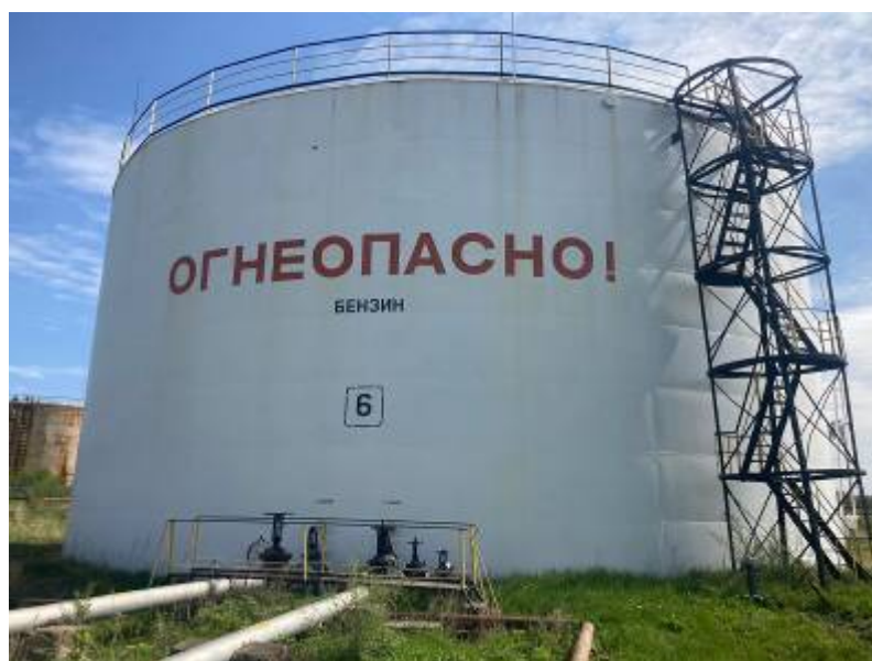
Рисунок 2 - Общий вид резервуара стального вертикального цилиндрического РВС-5000, Зав. № 6
