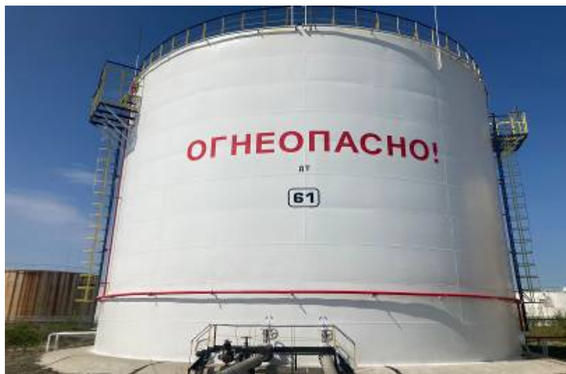
Рисунок 2 - Общий вид резервуара стального вертикального цилиндрического РВС-5000, Зав. № 61
