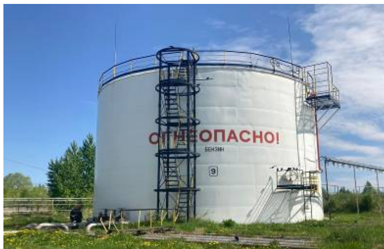
Рисунок 1 - Общий вид резервуара стального вертикального цилиндрического РВС-3000, Зав. № 9
