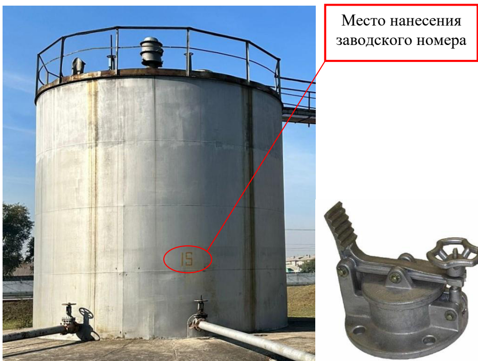
Рисунок 1 – Общий вид резервуара и замерного люка РВС-200 зав.№ 15
