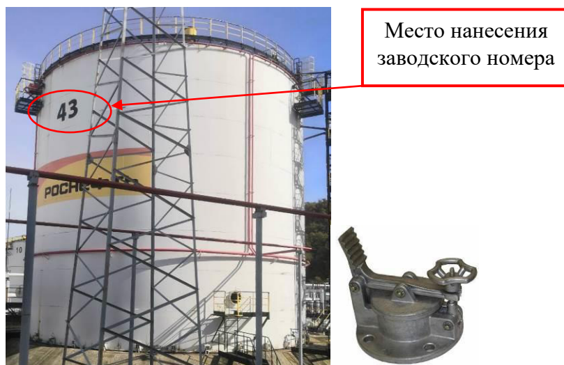
Рисунок 2 – Общий вид резервуара и замерного люка РВСП-5000 зав. № 43
