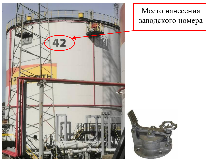
Рисунок 1 – Общий вид резервуара и замерного люка РВСП-5000 зав. № 42
