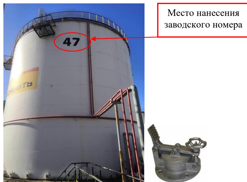
Рисунок 4 – Общий вид резервуара и замерного люка РВСП-5000 зав. № 47
