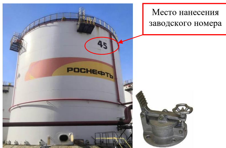
Рисунок 3 – Общий вид резервуара и замерного люка РВСП-5000 зав. № 45
