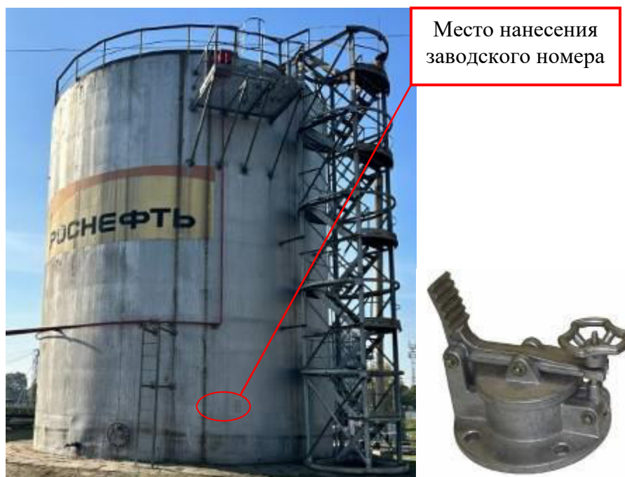
Рисунок 1 – Общий вид резервуара и замерного люка РВС-1000 зав.№ 8
