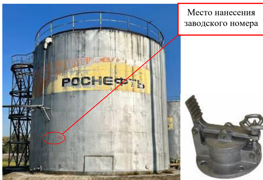
Рисунок 2 – Общий вид резервуара и замерного люка РВС-1000 зав.№ 16
