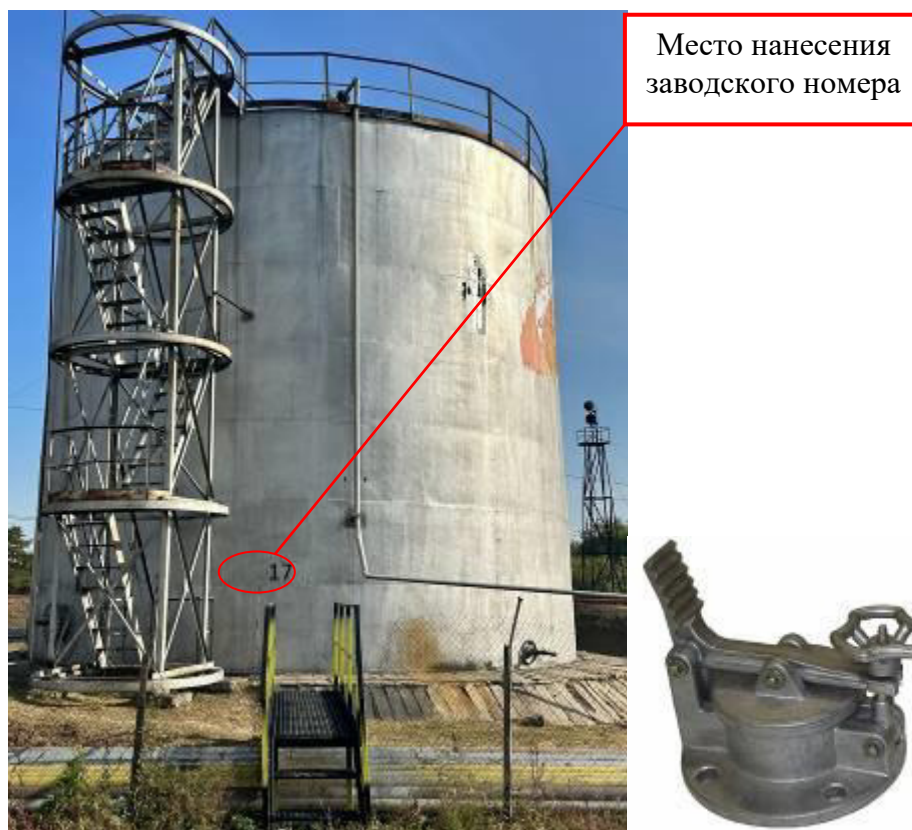
Рисунок 3 – Общий вид резервуара и замерного люка РВС-1000 зав.№ 17
